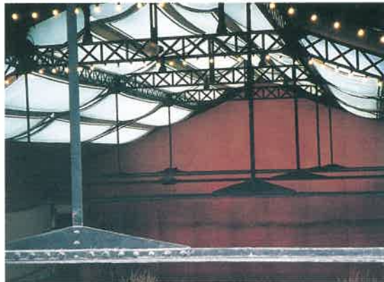
天井の全面に取り付けられた蛍光灯の照明
